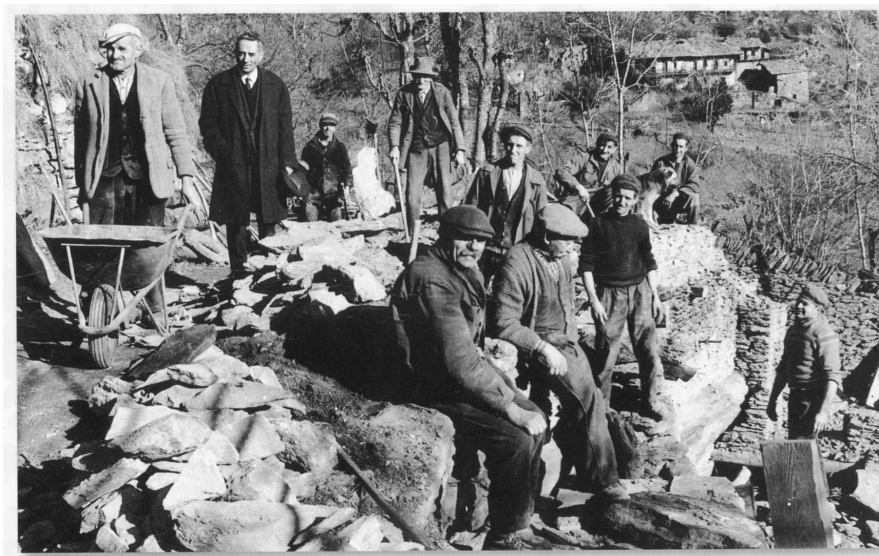
Borgata Bodeina/Comba. Costruzione della piazzola di partenza della teleferica del latte (1960). Da B. FRACHE, G. TOURN, Villar Pellice...si racconta , Torino, Claudiana, 2004.
