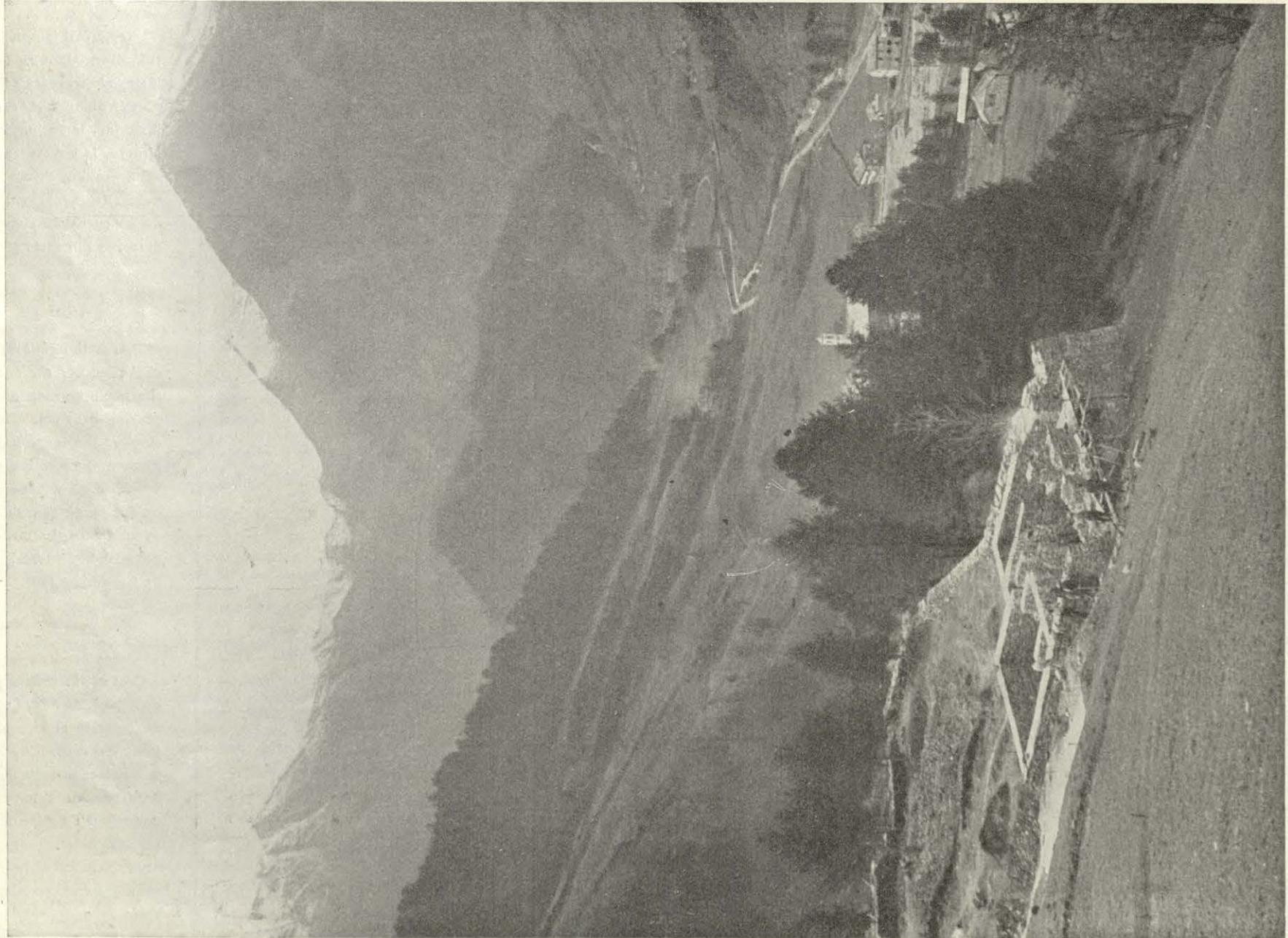
I lavori sono giunti presso a poco a questo punto. Nella foto si nota la grande opera di sbancamento nel monte, parte del muraglione della terrazza ed il magazzino.
