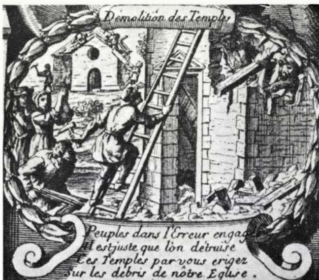
Demolizione di un tempio ugonotto.
