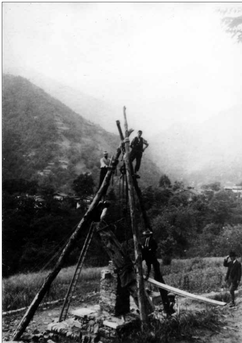
5. Monumento di Chanforan in costruzione: Paolo Paschetto sulla passerella, a destra Attilio Jalla; luglio 1932 (Archivio Fotografico Valdese).
