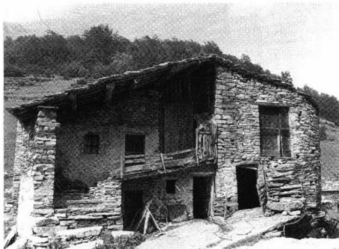
Fabbricato in località Garnirègna (Bobbio Pellice): il volume a destra è formato direttamente sul banco di roccia e presenta una soluzione d'angolo con muratura perimetrale curvilinea.
