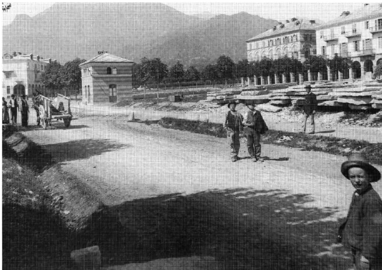
3. Airali. Piazza del Municipio, in costruzione. Oggi Piazza partigiani. A sinistra il peso pubblico, attualmente ufficio della Pro Loco. Nella foto odierna la strada e le case recenti coprono completamente i portici del municipio, un secolo fa perfettamente visibili (1875 --17 settembre 1998).
