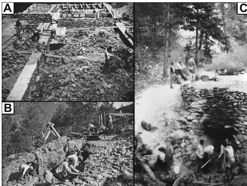
4 - Foto storiche del cantiere agapino in costruzione. A: realizzazione delle fondamenta del salone centrale sul detrito di versante (Bleynat, 1948); B: realizzazione delle fondamenta della cucina. Si noti in alto la teleferica (Bleynat, 1948); C: la fornace della calce in funzione presso la località Maniglia di Perrero il 30 agosto 1947 (Archivio del Centro Ecumenico Agape). Abbondante legante idraulico nelle fughe (P. Montesanto, 2012).
