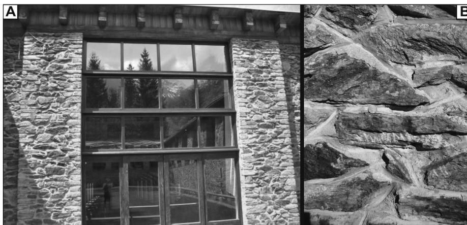
5 - Murature esterne del Centro Ecumenico Agàpe. A: finestrone a vetrate che si affaccia sulla chiesa all'aperto; B: dettaglio delle murature: le pietre utilizzate, costituite da micascisti e gneiss minuti del massiccio Dora-Maira, sono state prelevate dal detrito eluvio-coluviale presente in loco. Si noti la lavorazione a spacco naturale dei conci e la presenza di abbondante legante idraulico nelle fughe (P. Montesanto, 2012).
