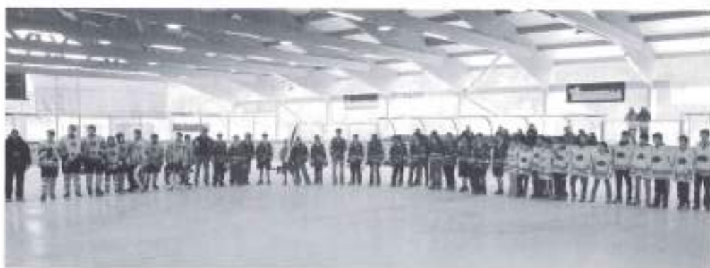
Lo stadio del Filatoio ha avuto, nella sua storia, due coperture: la prima, infatti, fu spazzata via dall'alluvione del 2000.
