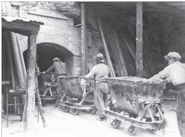
Imbocco della galleria Gianfranco. Archivio dell'Ecomuseo delle Miniere della Val Germanasca.
